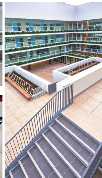
1階から4階までが階段で行き来が可能となる
